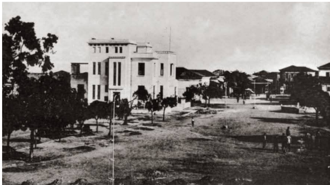
Το κτήριο της Εθνικής Τράπεζας Μεσσήνης που οχυρώθηκαν Γερμανοί και ταγματاسφαλίτες
